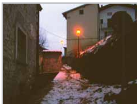
Nuovo impianto di illuminazione a Grimolto
