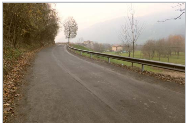
Allargamento strada per Stabello
