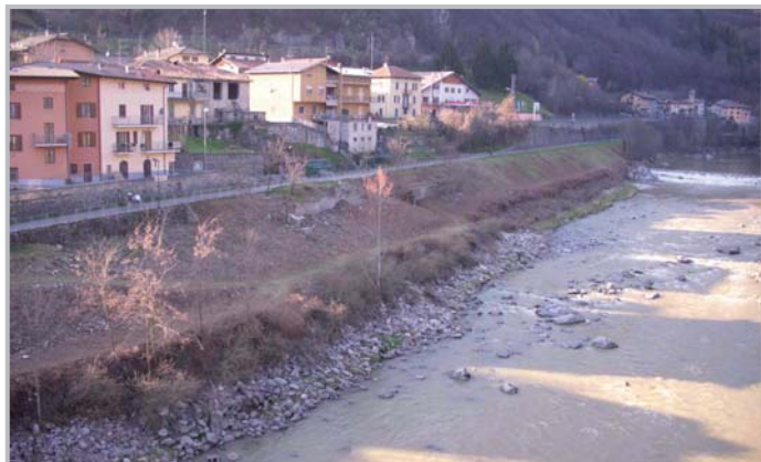
Pulizia dell'argine Brembo
