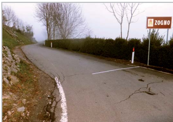
Messa in sicurezza strade
