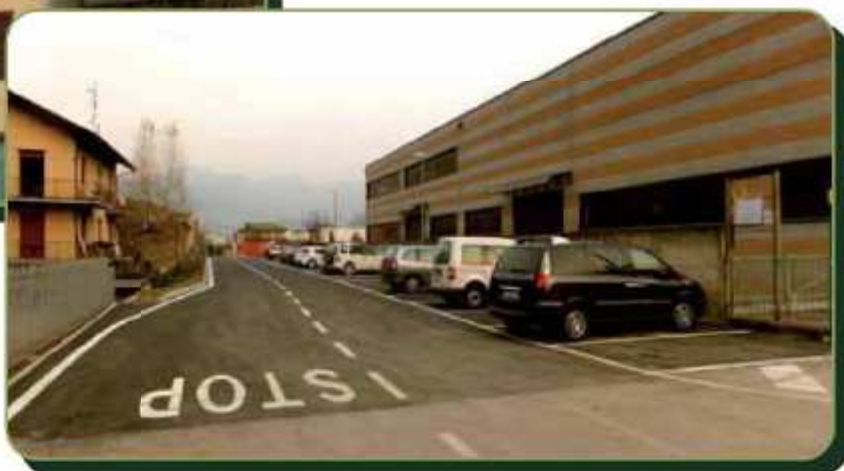
Realizzazione nuovo parcheggio di Via Locatelli - Zona Carmine (intervento pubblico a carico di privati)
