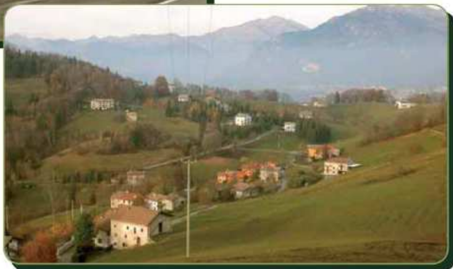
Collettamento rete fognaria Miragolo San Marco - via Castello - via Gritti 225.000 €
