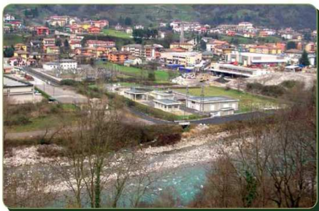
Depuratore vallare di Via Locatelli: Riqualificazione e manutenzione accesso-allacciamento servizi 100.000 €
