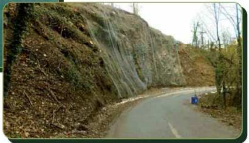
Messa in sicurezza scarpate e versante strada Castegnone 61.000 €
