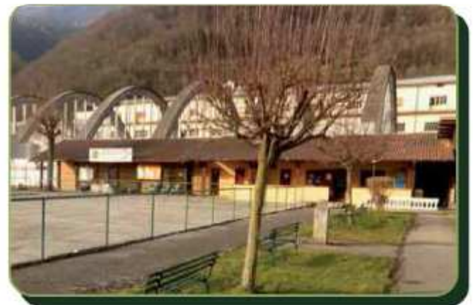
Sostituzione caldaia e adeguamento normativo centrale termica Centro Sportivo P. Polli 17.600 €
