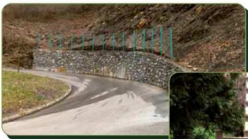
Messa in sicurezza strada per Tessi - Spino al Brembo 36.000 €
