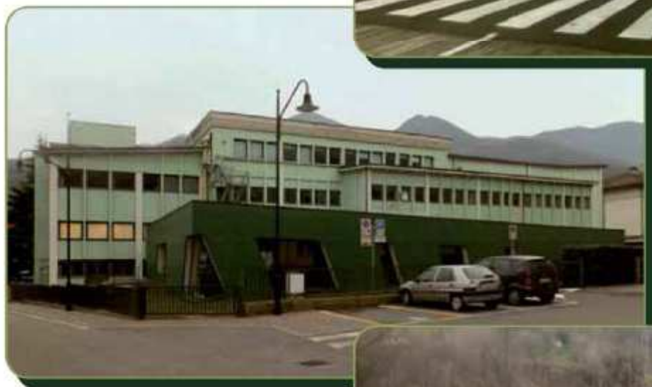
Interventi vari per la messa in sicurezza degli edifici scolastici 15.000 €
