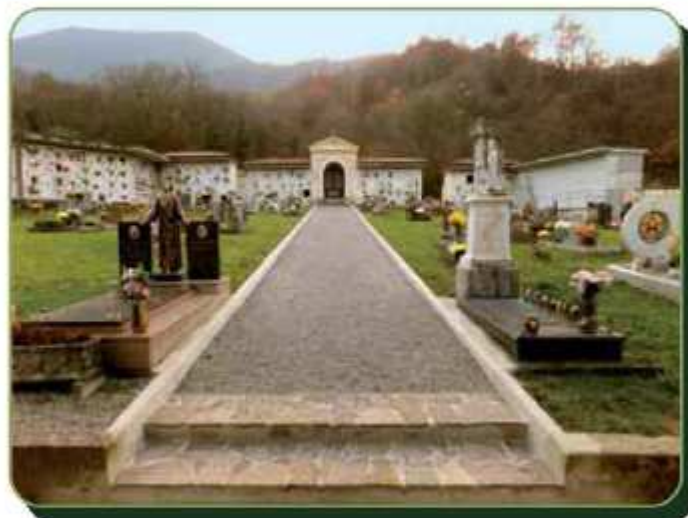
Costruzione nuovi loculi e ossarietti con opere di manutenzione straordinaria al cimitero di Poscante 97.000 €
