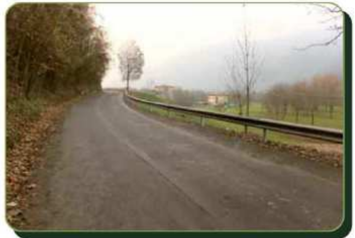
Ampliamento strada Stabello loc. Piazza Monaci (intervento pubblico a carico di privati)
