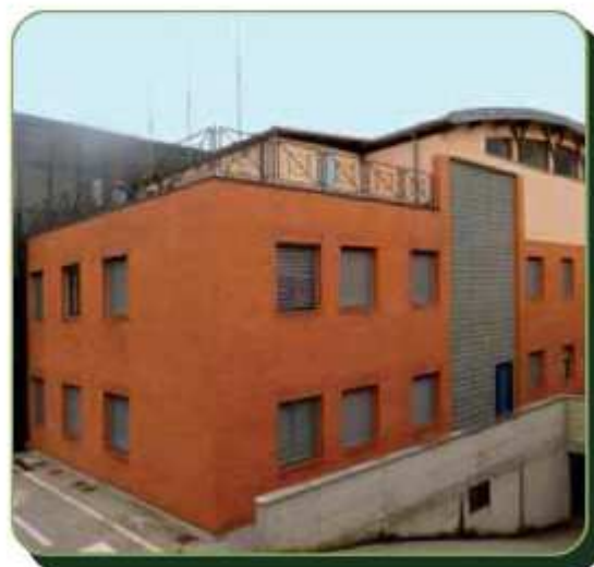
Copertura e manutenzione locali tecnici "Centro Servizi" di viale Martiri della Libertà 20.000 €
