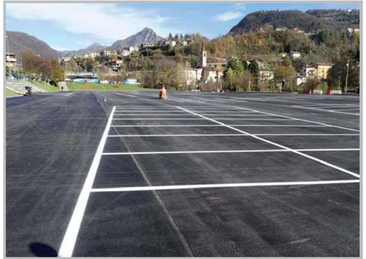
Asfaltatura parcheggio area mercato
