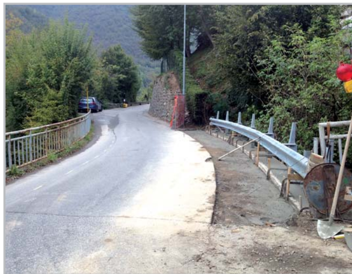
Messa in sicurezza versanti
