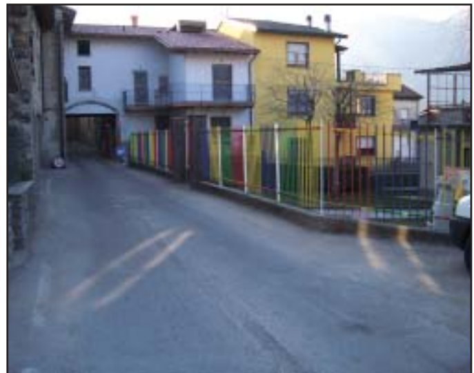
Stabello Percorso pedonale in via Centro € 45.000,00
