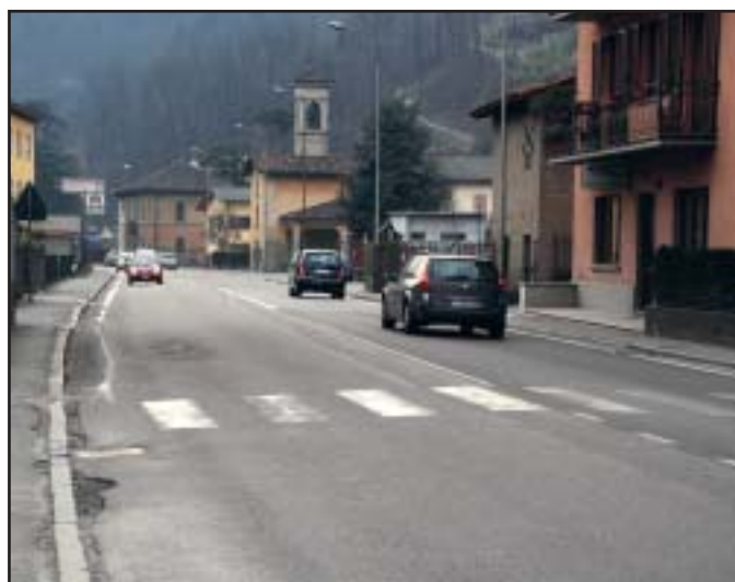
Via A.Locatelli - Realizzazione nuovo tratto di Fognatura - Tombinatura € 50.000,00
