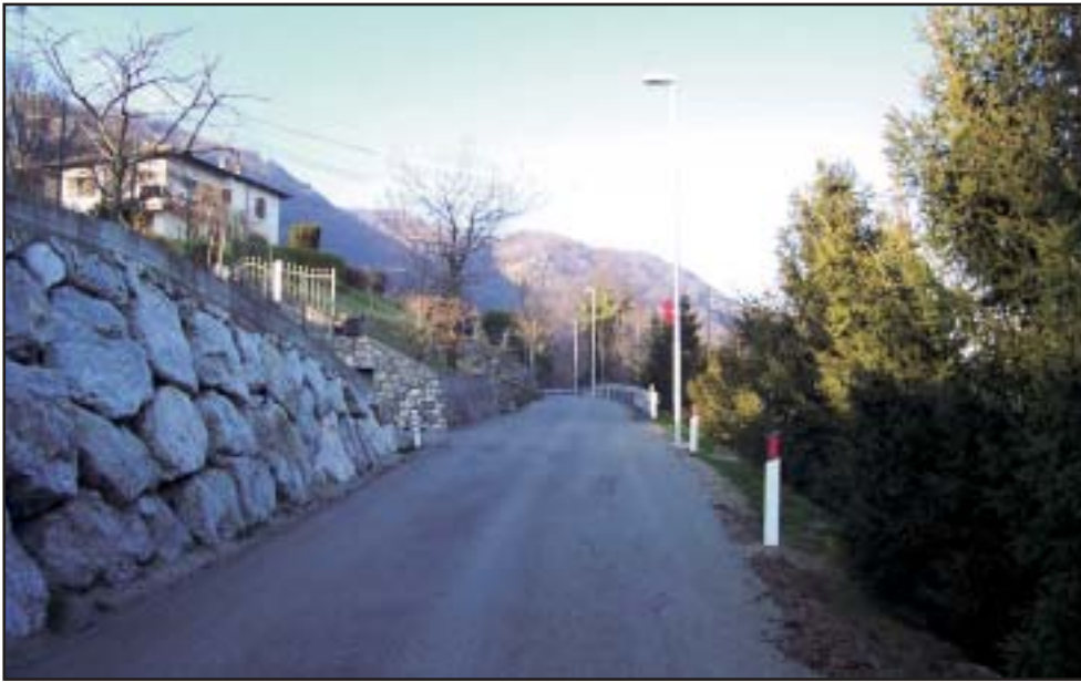
Poscante Pratogrande-Lallio, monte di Zogno contrade Cornelle, Tiglio e Colle, Spino via per Bracca, Somendenna via Bregni, Stabello via Ere, Pradelli e Contrada Angelini impianti di pubblica illuminazione
