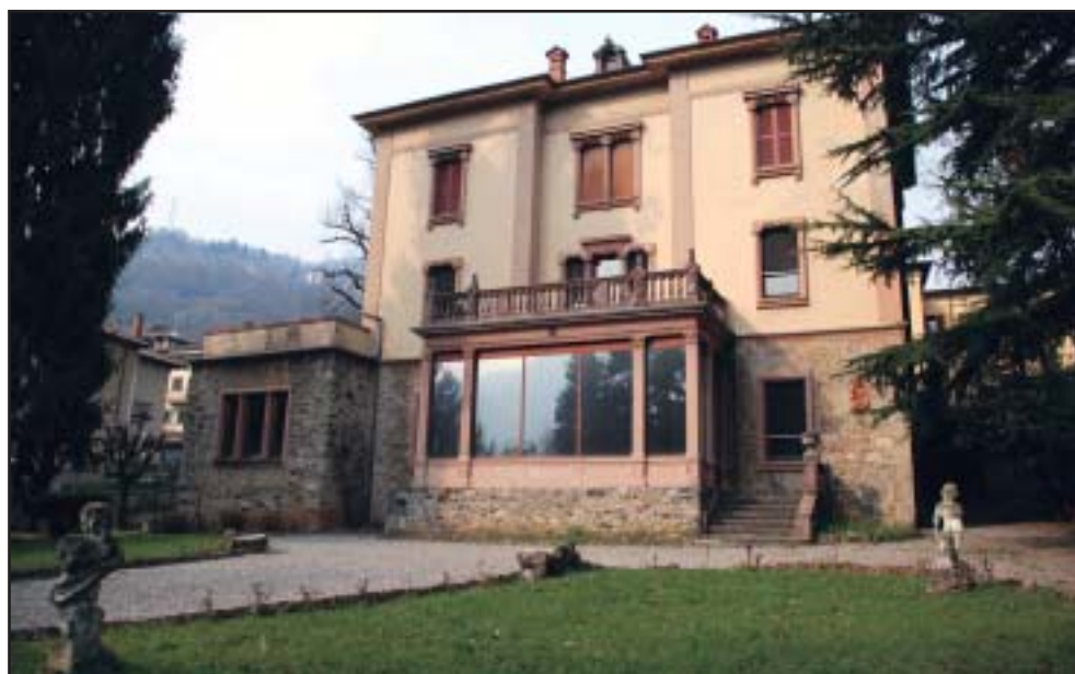
Biblioteca Sostituzione caldaia € 14.000,00
