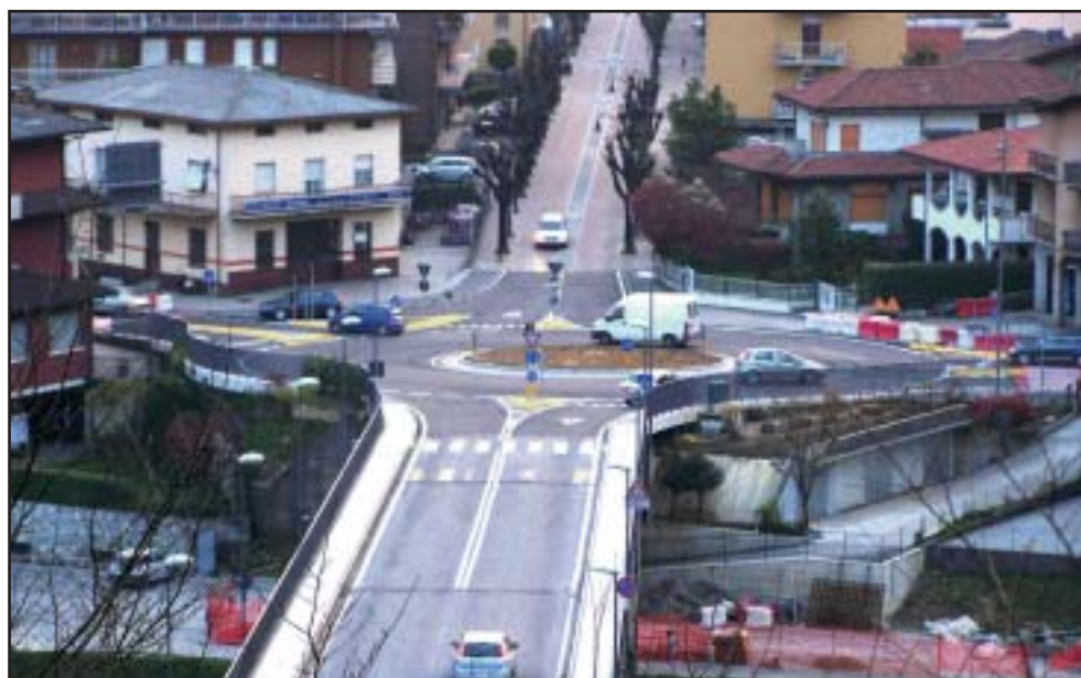
Ponte nuovo Realizzazione rotatoria € 575.000,00
