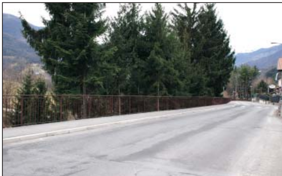
Endenna Marciapiede via Ronco con rifacimento asfalto strada € 118.000,00
