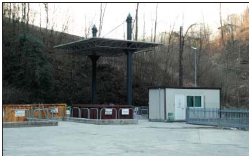
Piazzola ecologica Copertura e adeguamento recinzione € 35.000,00
