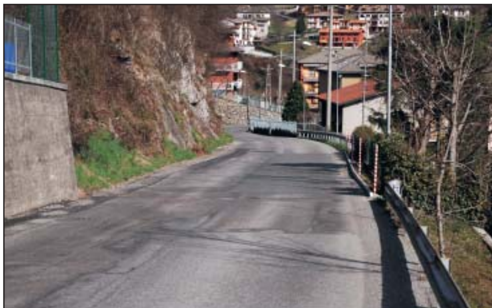
Via Campelmè Rifacimento tratto di fognatura € 22.000,00
