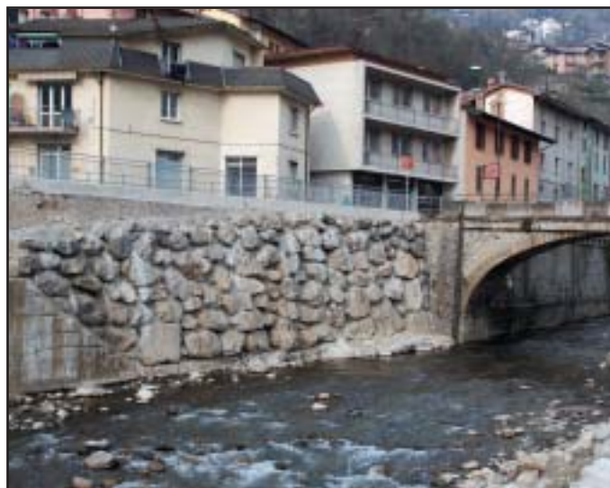
Ambria - Ricostruzione muro franato e sistemazione parcheggio € 38.800,00
