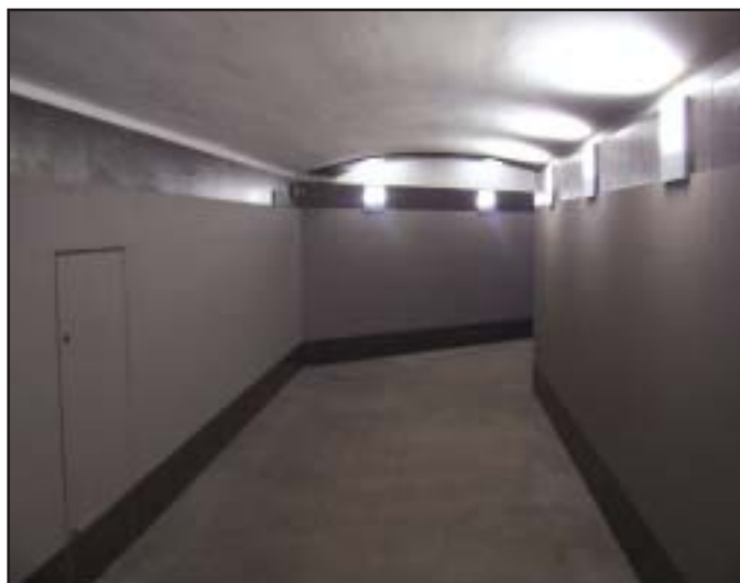
Sottopasso Integrazione impianto di videosorveglianza € 19.000,00
