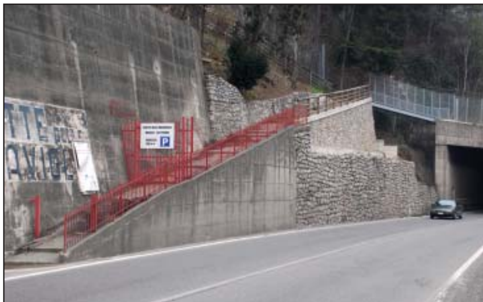
Via Grotte delle Meraviglie Messa in sicurezza sentiero di accesso alle Grotte delle meraviglie € 73.000,00
