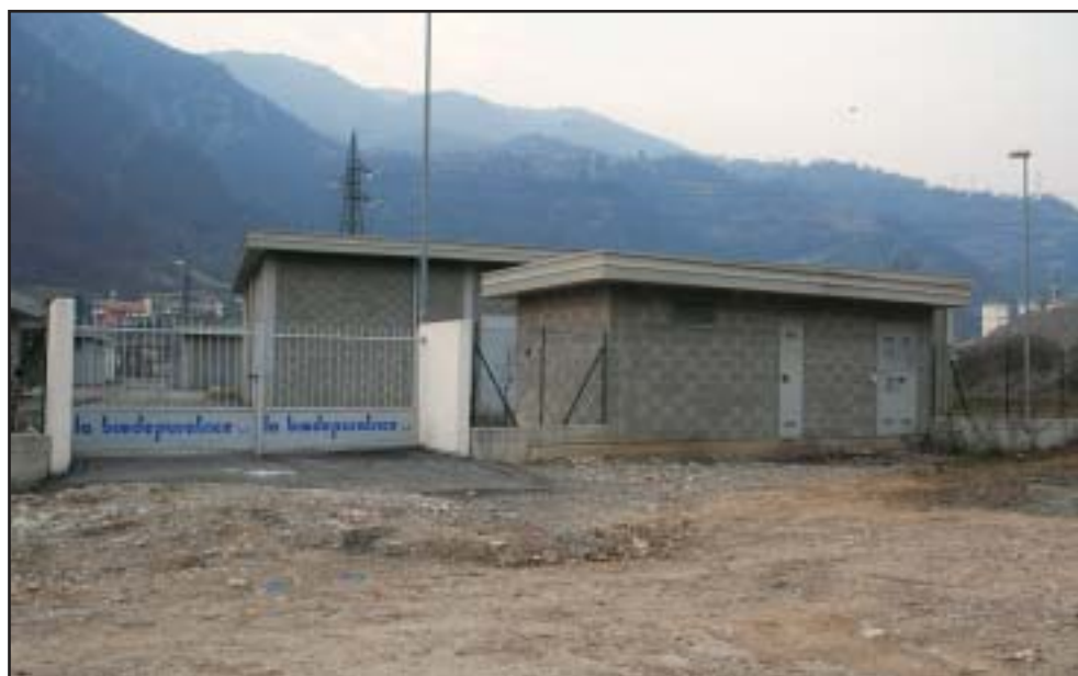
Depuratore Costruzione cabina elettrica € 61.000,00
