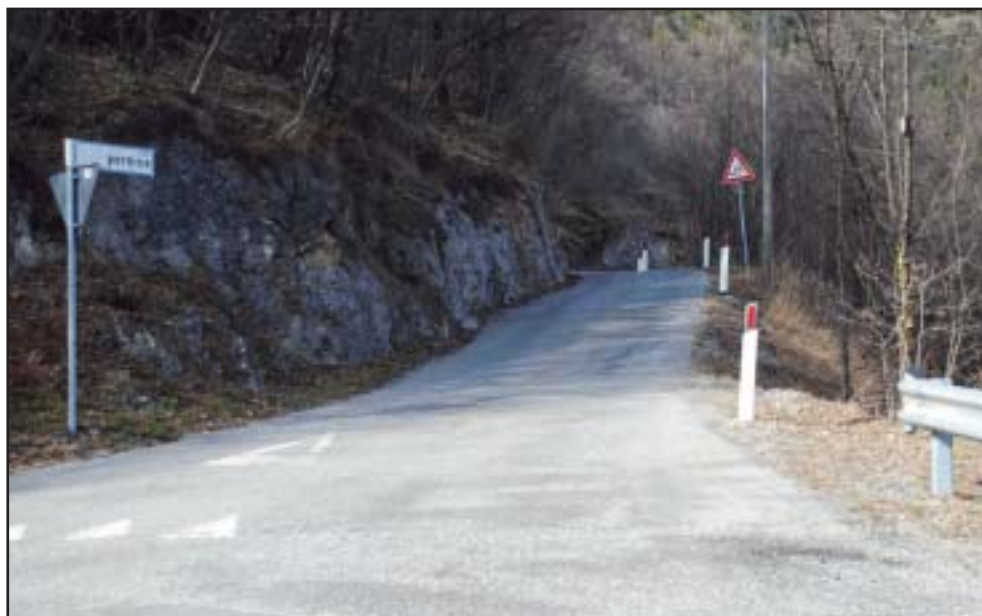
Monte di Zogno Messa in sicurezza strada del monte € 35.000,00
