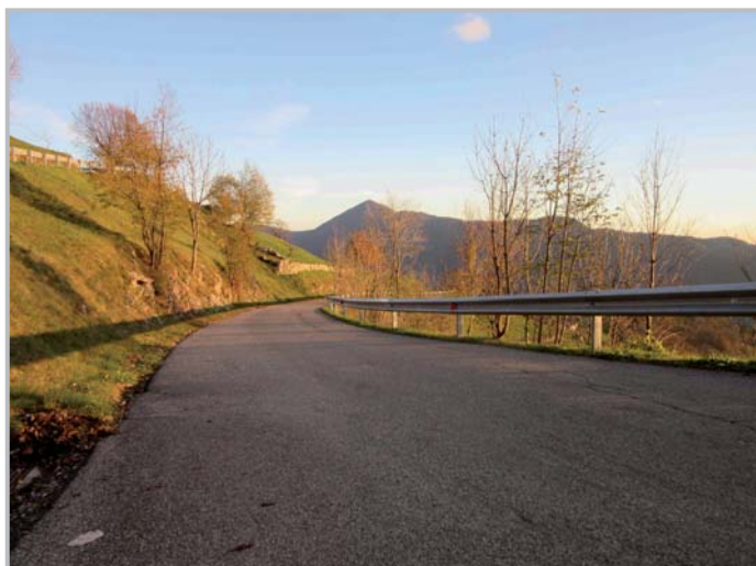
Messa in sicurezza strade
