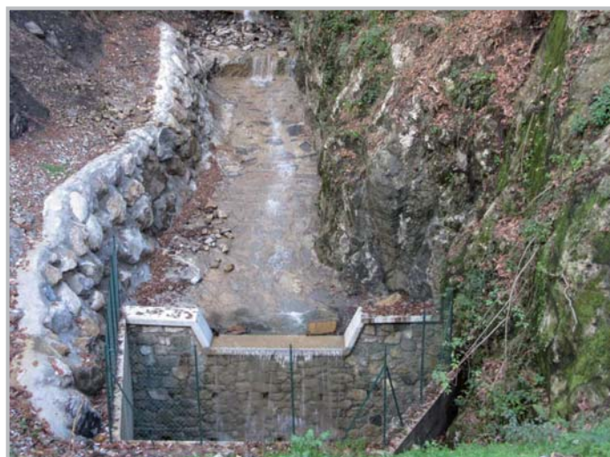
Messa in sicurezza della Valle Carubbo a Camissinone
