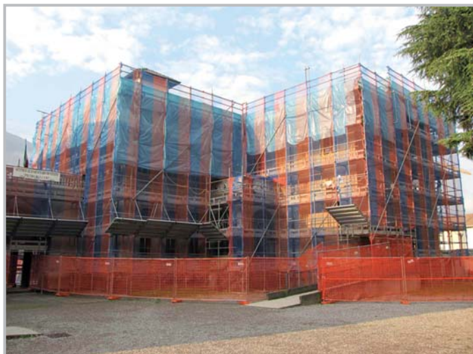
Il cantiere delle scuole di Via Roma
